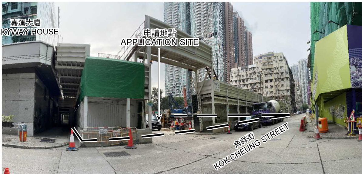
照片 2 — 申請地點 PHOTO 2 - APPLICATION SITE
