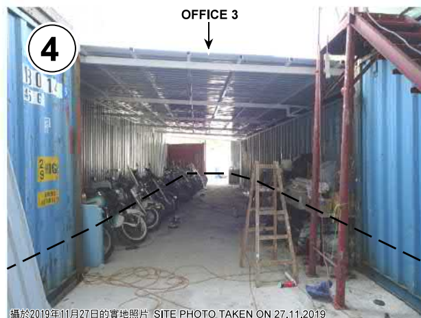
攝於2019年11月27日的實地照片 SITE PHOTO TAKEN ON 27.11.2019
