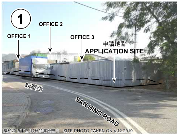
攝於2019年12月4日的實地照片 SITE PHOTO TAKEN ON 4.12.2019
