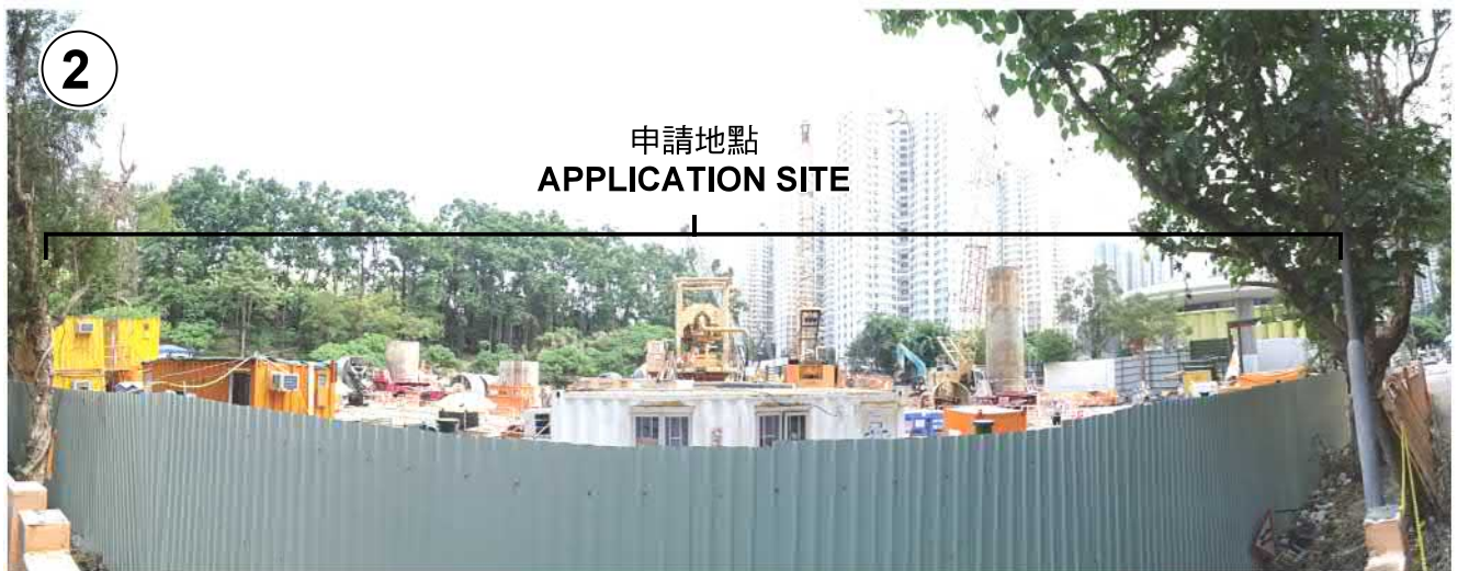
攝於2019年10月3日的實地照片 SITE PHOTO TAKEN ON 3.10.2019
