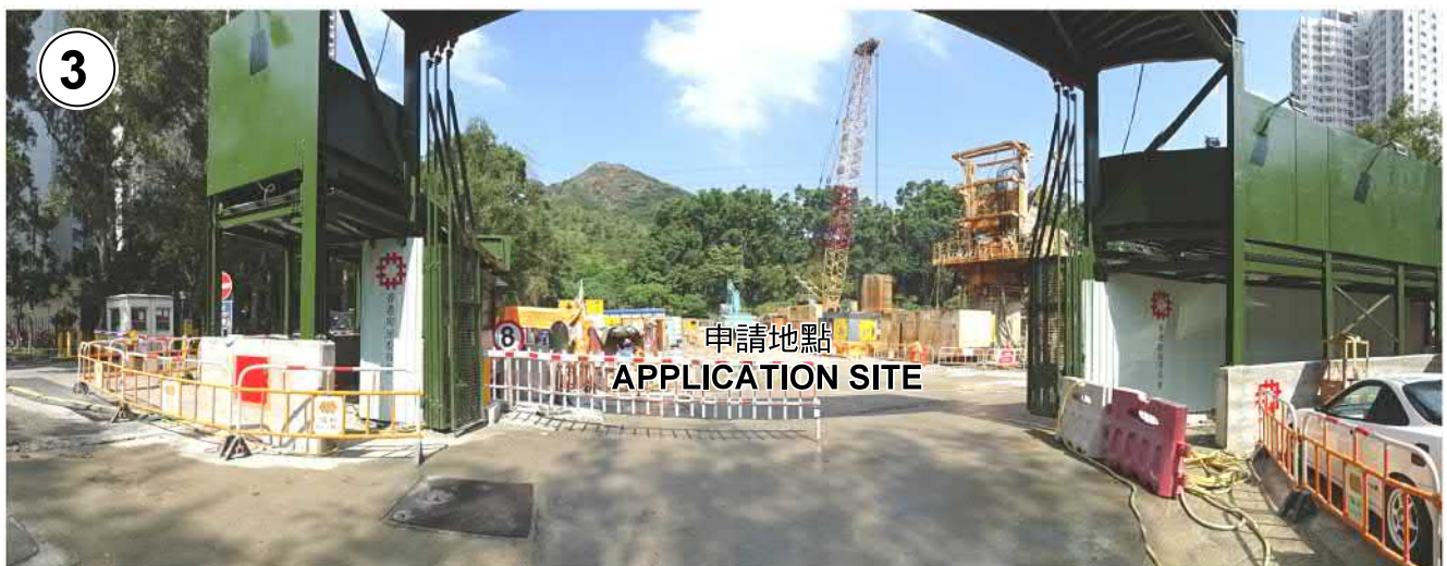
攝於2019年10月15日的實地照片 SITE PHOTO TAKEN ON 15.10.2019
