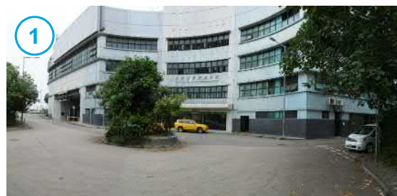
路政署、機電工程署及建築署的維修廠 HyD / EMSD / ArchSD MAINTENANCE DEPOT
