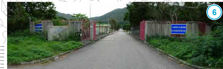
小蠔灣污水處理廠 SIU HO WAN SEWAGE TREATMENT WORKS
