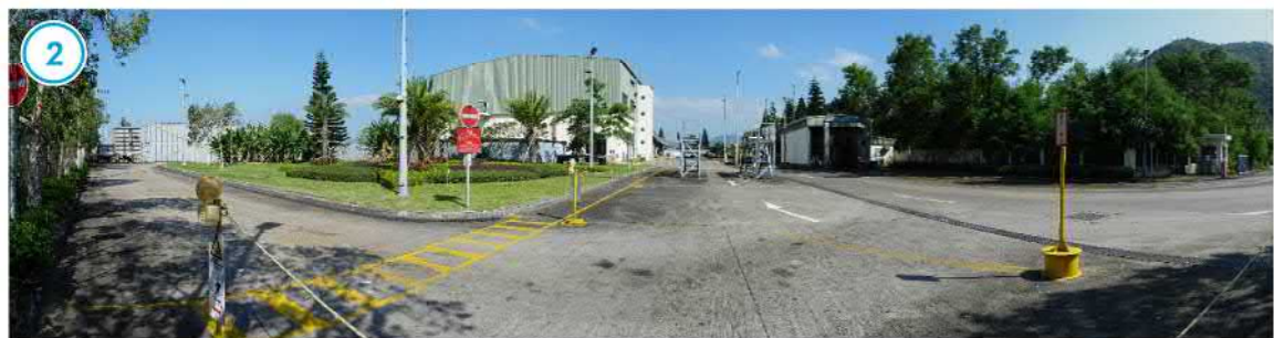
北大嶼山廢物轉運站 NORTH LANTAU REFUSE TRANSFER STATION
