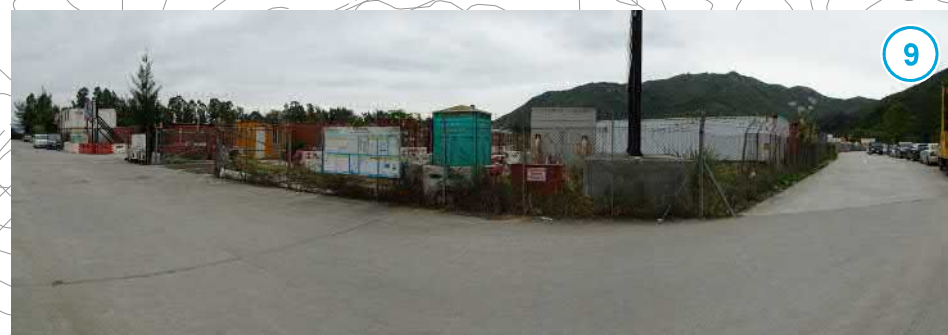
路政署的港珠澳大橋工程臨時工地 TEMPORARY HyD HKZMB WORKS AREA
