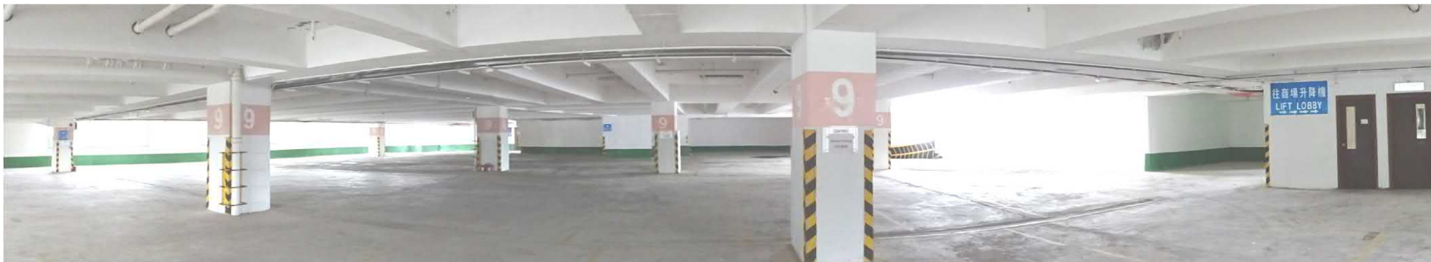
申請地點（九樓室內） APPLICATION SITE (INTERIOR AT 9/F)
