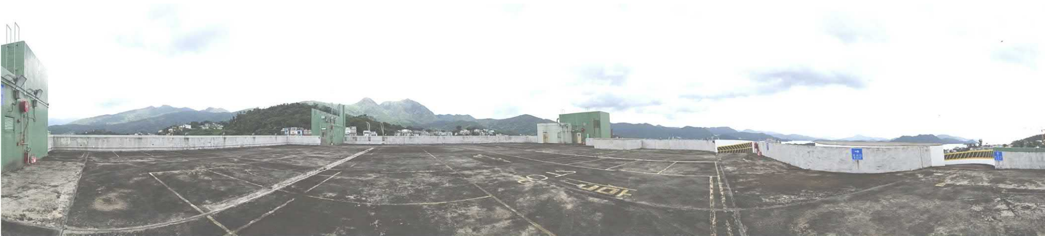
申請地點（天台） APPLICATION SITE (ROOFTOP)
