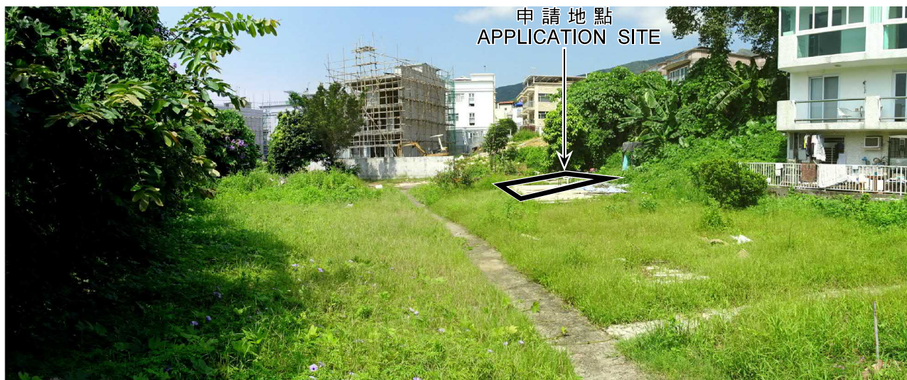
攝於2018年7月11日的實地照片 SITE PHOTO TAKEN ON 11.7.2018
