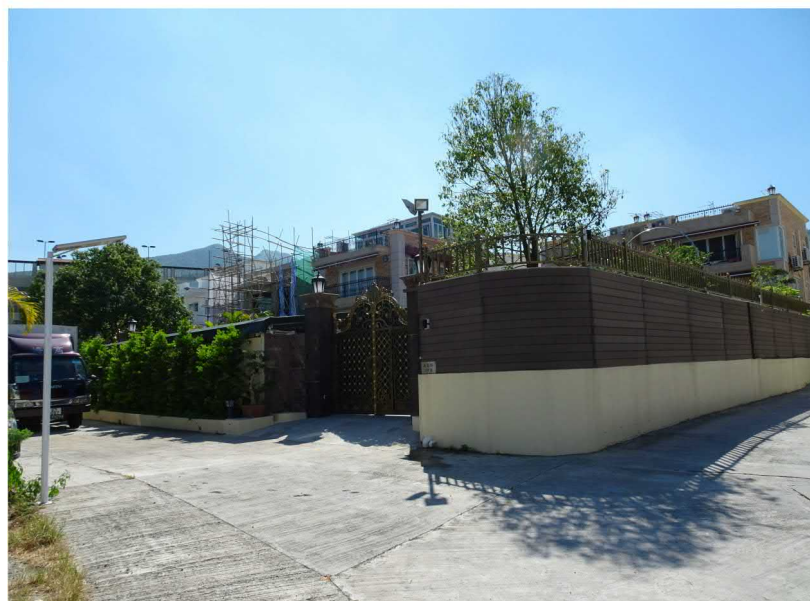
攝於2018年5月30日的實地照片 SITE PHOTO TAKEN ON 30.5.2018
