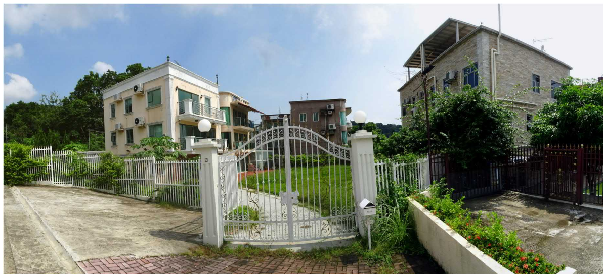
攝於2018年9月5日的實地照片 SITE PHOTO TAKEN ON 5.9.2018
