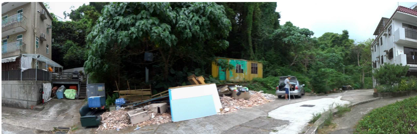
攝於2018年6月1日的實地照片 SITE PHOTO TAKEN ON 1.6.2018
