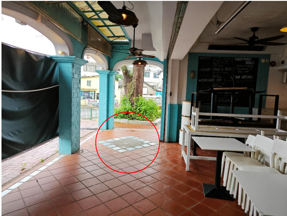
03. Foul Water Tank (D)
