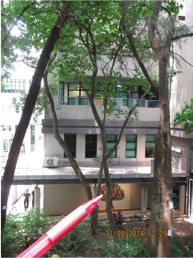
NS108 (OVERALL VIEW)
