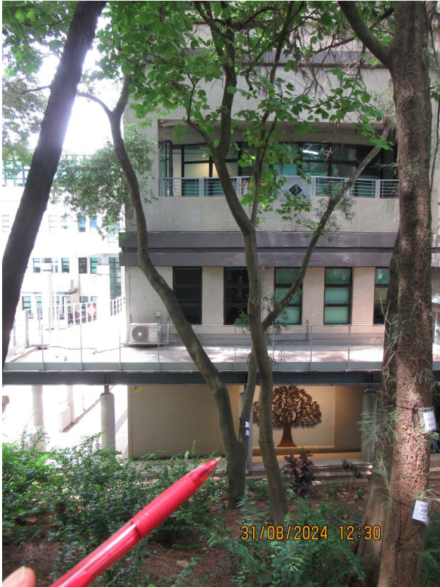
NS109 (OVERALL VIEW)
