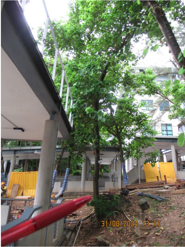
NS213 (OVERALL VIEW)
