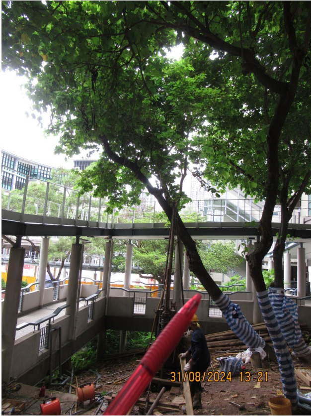
NS214 (OVERALL VIEW)
