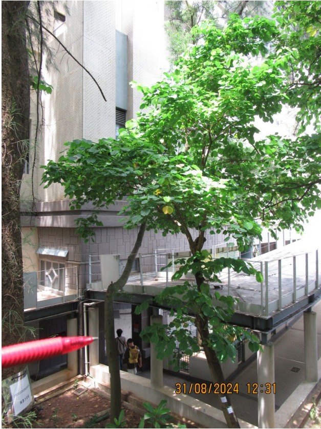
NS191 (OVERALL VIEW)
