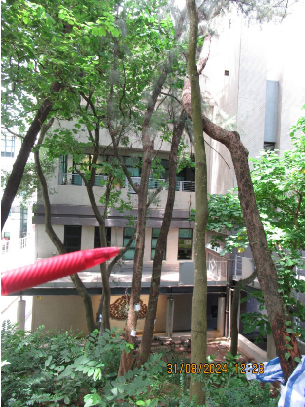
NS106 (OVERALL VIEW)
