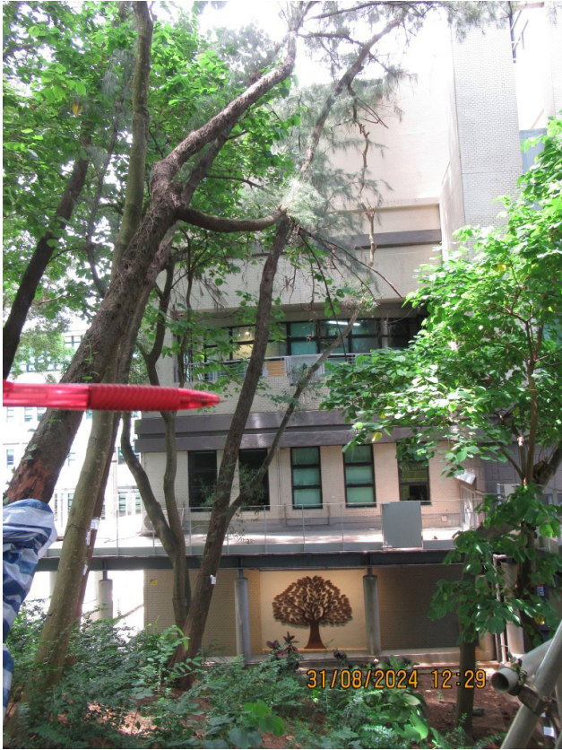
NS107 (OVERALL VIEW)
