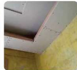
为什么吊顶转角石膏板要用“L”型-装修保障网
