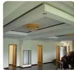
石膏板吊顶好不好? 石膏板吊顶安装方法_装修之家网
