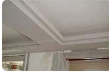
吊顶石膏板品牌有哪些?石膏板吊顶步骤? - 房天下装修知识
