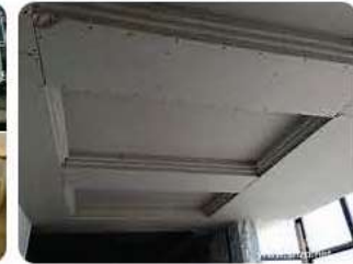
装石膏板吊顶要不要刮腻子? 原来工人都是怎么做的-上海装潢网
