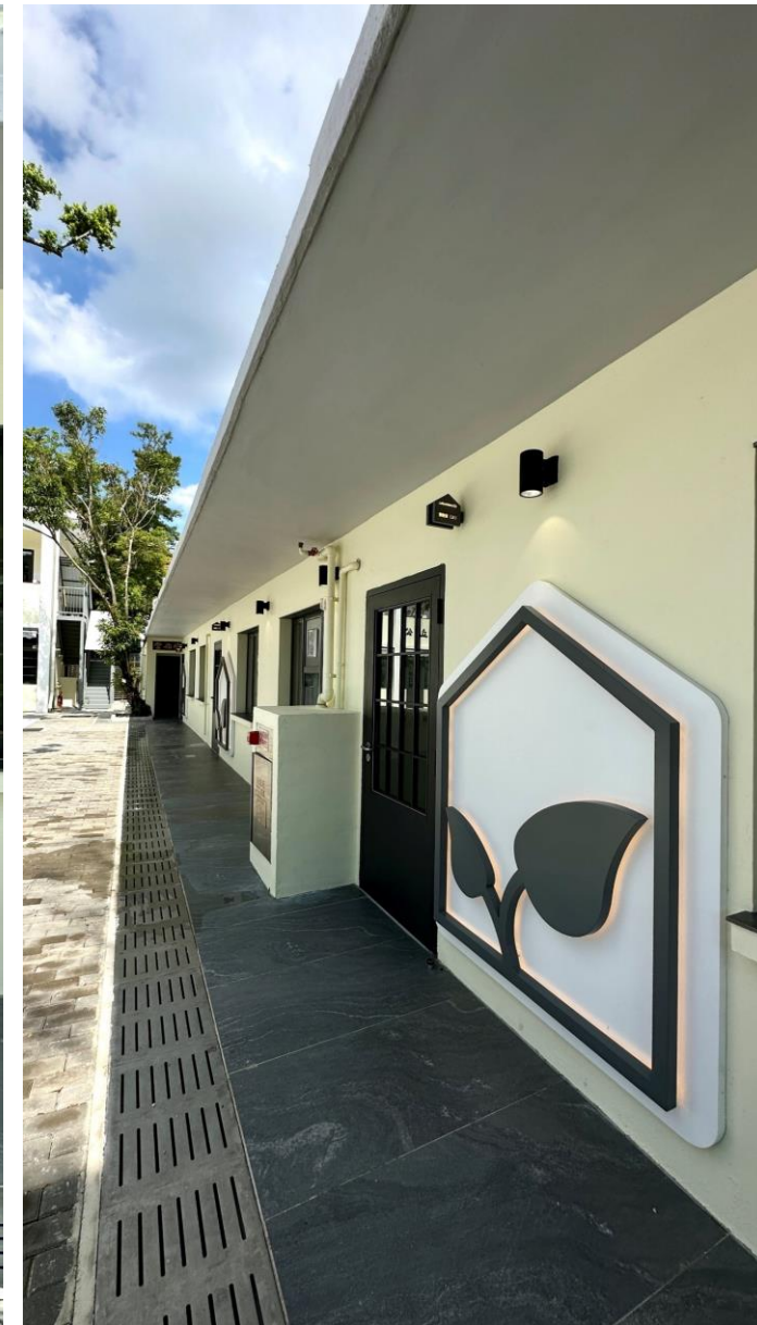
V2 BLOCK B EXTERIOR
