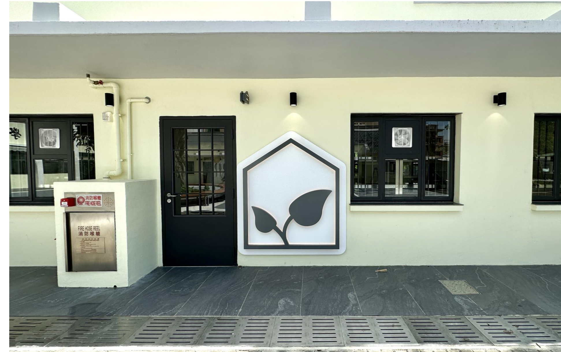
V1 BLOCK B EXTERIOR
