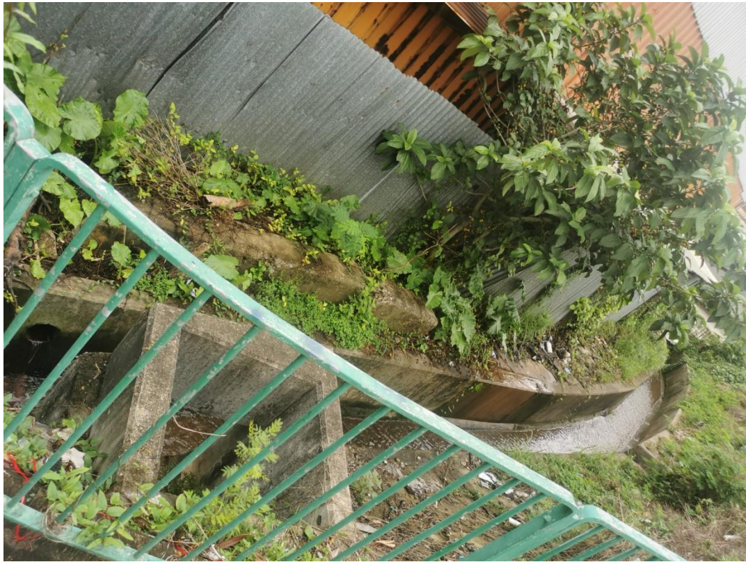
圖 13 接駁了公共雨水渠。
