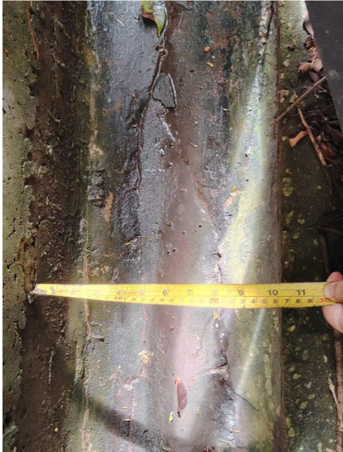
圖 6 渠道闊度為 30cm，渠道深度約 30cm
