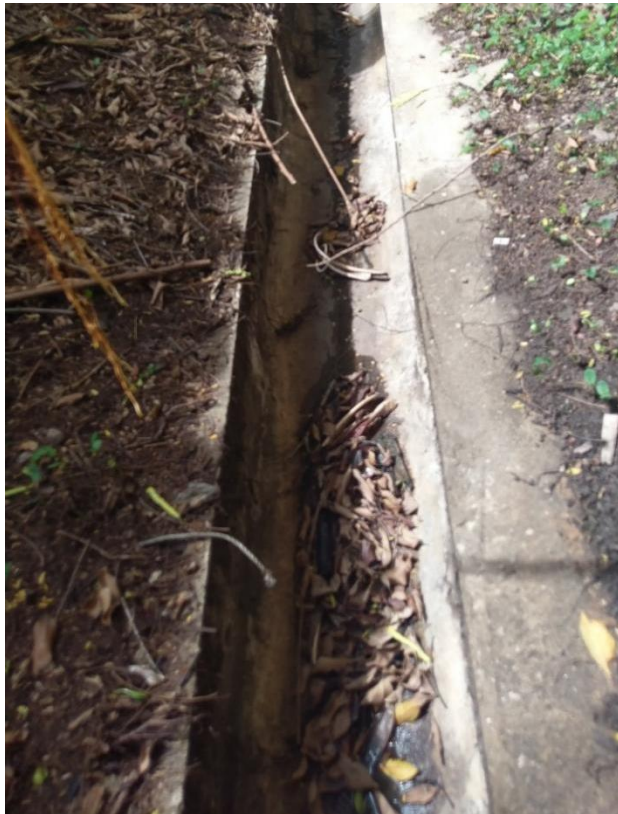
圖 6 渠道闊度為 30cm，渠道深度約 30cm
