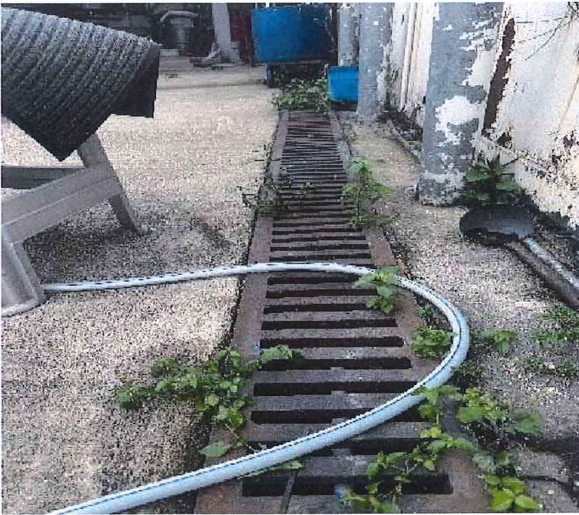
圖示 2 號位 200mm U 型明渠
