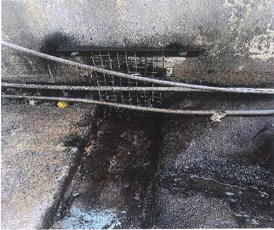
暗渠通道出口
