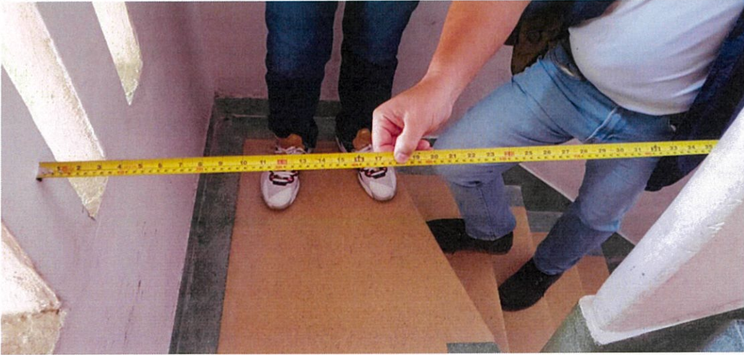
樓梯寬不到1米
