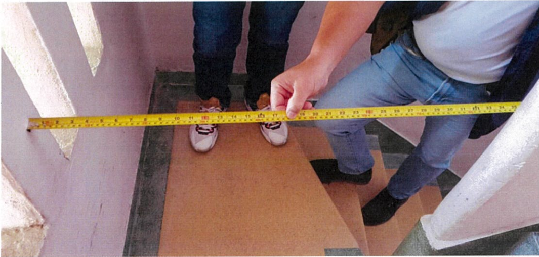
樓梯寬不到1米
