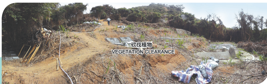
移除植物及 鋪設混凝土板 Vegetation Clearance and Concrete Slabs
